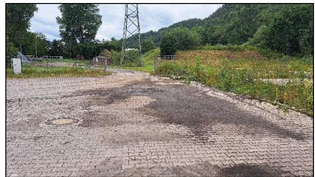
Abbildung 8: Wendehammer und Hochspannungsmast
