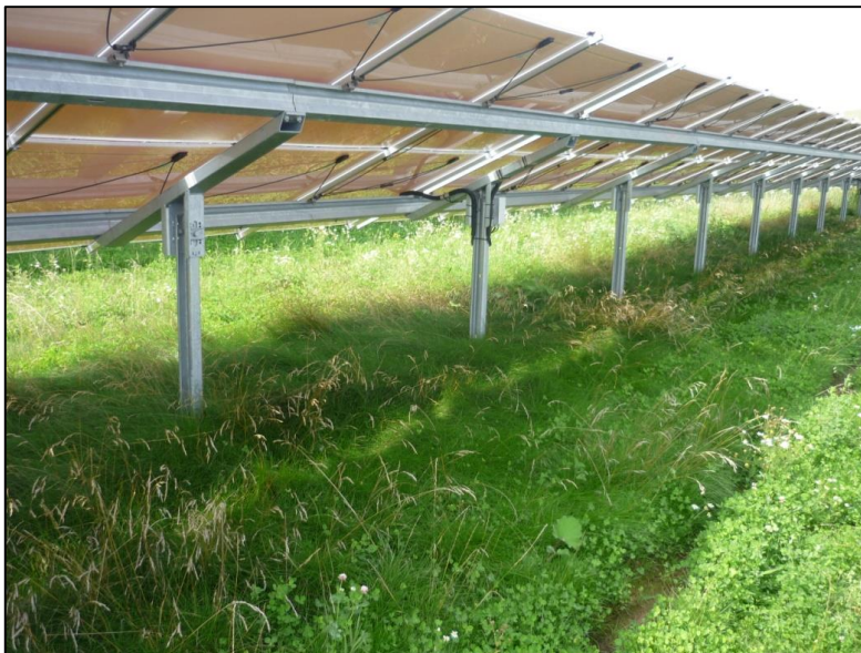
Abbildung 5: Beispiel der Aufständigung von Solarmodulen (Bereich Solarpark Ronneburg Süd) – Die Aufständigung erfolgt entsprechend für Solarkollektoren.
