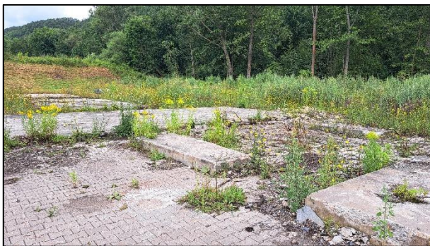
Abbildung 7: Betonfundamente im Plangebiet
