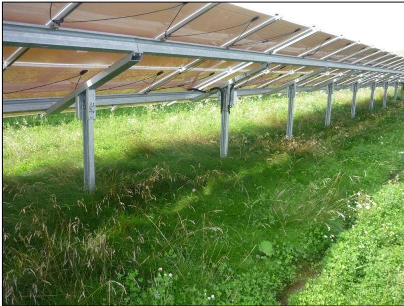
Abbildung 5: Beispiel der Aufständigung von Solarmodulen (Bereich Solarpark Ronneburg Süd). Der Abstand zwischen den Modulen wird so breit gewählt, dass kein Schattenwurf auf die benachbarten Module erfolgt. Die Abstandsflächen aber auch die Flächen unter den Modulen stehen dem Naturhaushalt weiterhin zur Verfügung (Lebensraum, Versickerung etc.).
