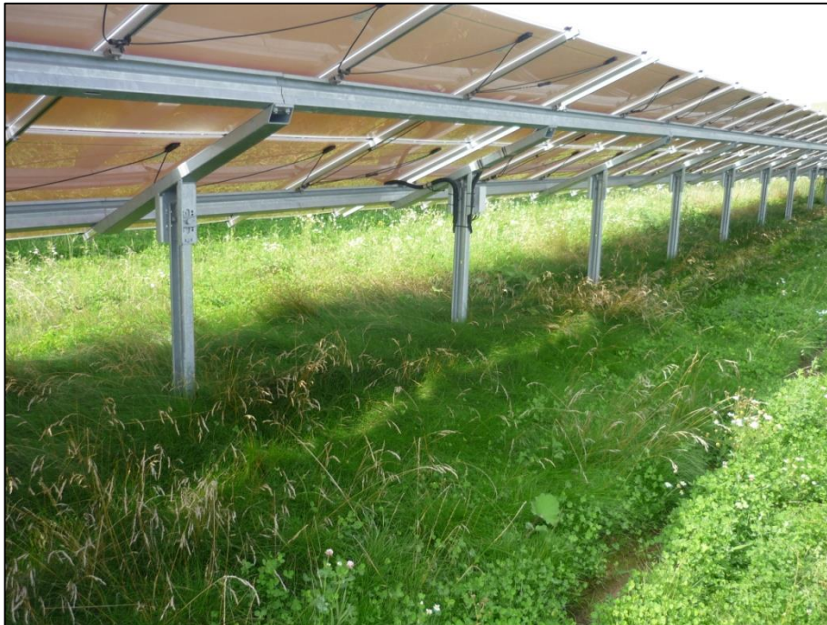
Abbildung 7: Beispiel der Aufständigung von Solarmodulen (Bereich Solarpark Ronneburg Süd). Der Abstand zwischen den Modulen wird so breit gewählt, dass kein Schattenwurf auf die benachbarten Module erfolgt. Die Abstandsflächen aber auch die Flächen unter den Modulen stehen dem Naturhaushalt weiterhin zur Verfügung (Lebensraum, Versickerung etc.).
