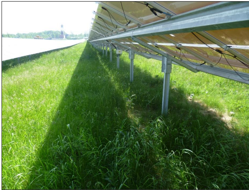
Abbildung 4: Beispiel der Aufständerung von Solarmodulen (in Ronneburg, Thüringen).
