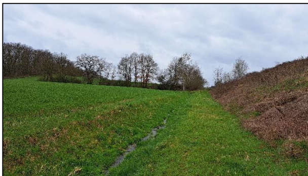
Abbildung 11: Entwässerungsgraben um die Deponie (hier am Nordrand)
