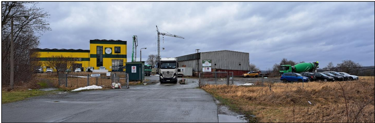
Abbildung 6: Blick auf den Änderungsbereich von der Zufahrtsstraße im Süden
