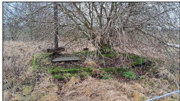
Abbildung 8: Abdeckung des Schachts 391
