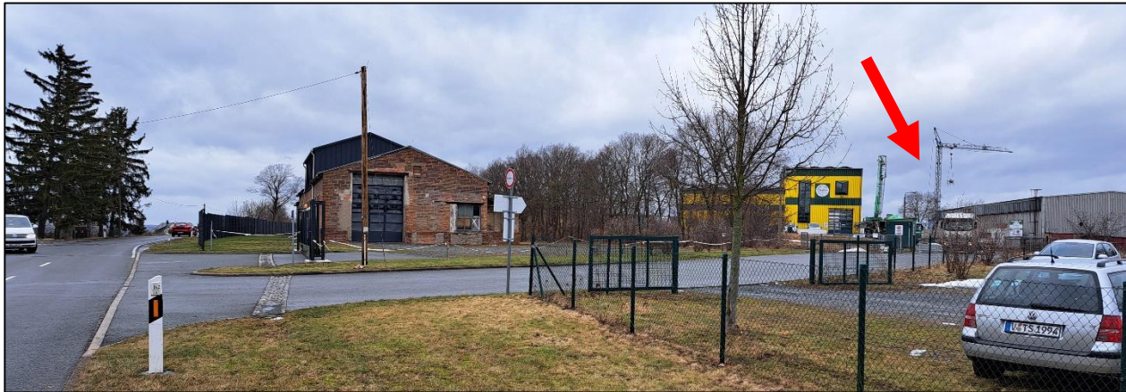
Abbildung 9: Blick von der K 7806 in Richtung des Plangebiets (roter Pfeil)
