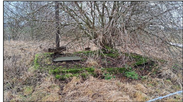
Abbildung 10: Abdeckung des Schachts 391
