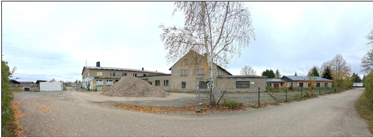
Abbildung 9: Blick auf das Plangebiet von Norden am Ende des Poserwegs
