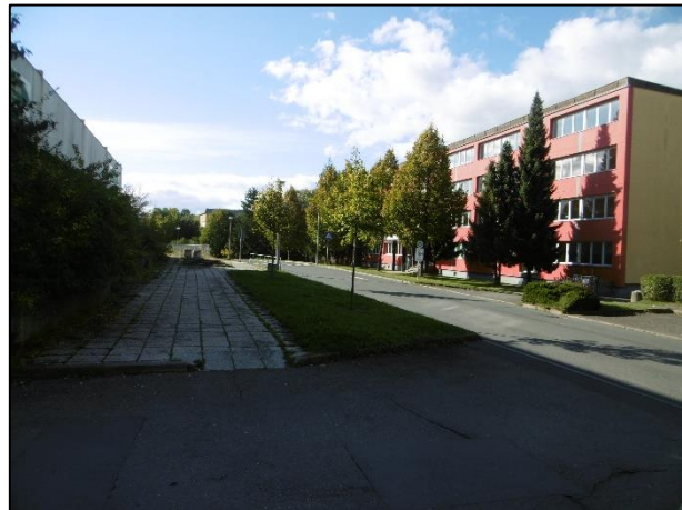
Abbildung 8: Julius-Fucik-Straße (Plangebiet links im Bild)
