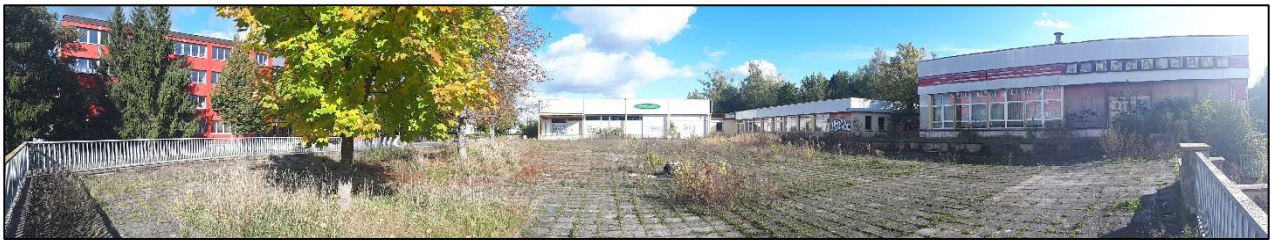
Abbildung 15: Blick über die ungenutzten Gewerbeflächen des Plangebietes (Panoramaaufnahme)
