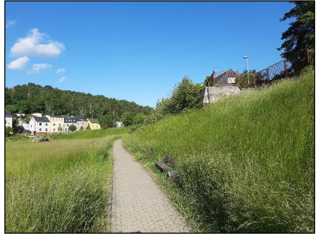
Abb. 11: südliche Böschung mit Gehölzen
