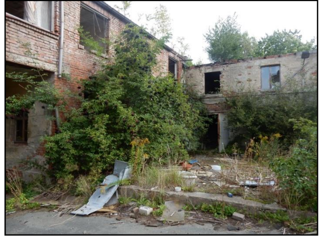
Abb. 8: versiegelte Fläche zwischen Gebäuderuinen im östlichen Geltungsbereich
